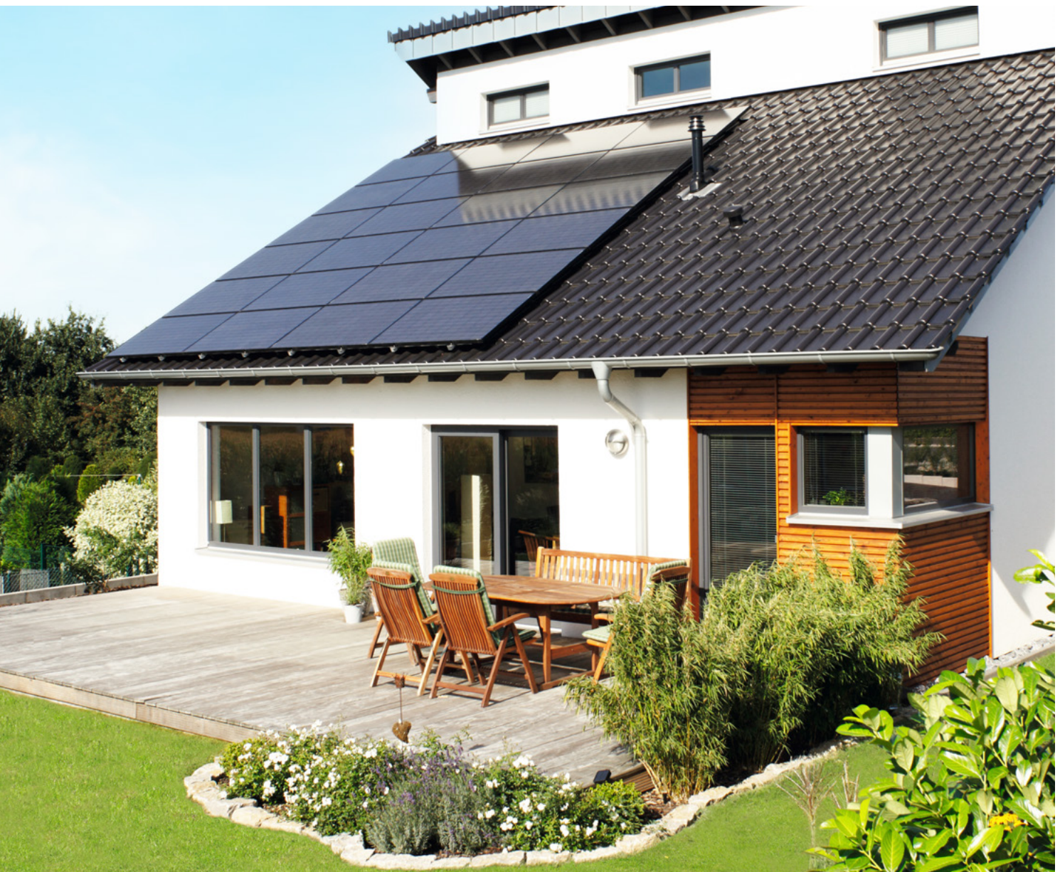
Dachinstallation der PV-Anlage zur Nutzung des Sonnen PV-Stroms.
